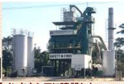
【インドネシアに建設したリサイクルアスファルトプラント】
