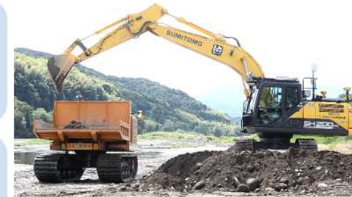
遠隔操作で進められる工事の様子(写真:旭建設)
