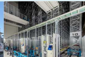
立体自動倉庫(岡山営業所)
